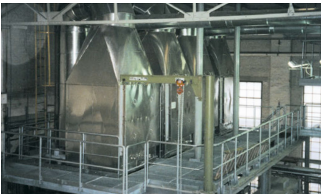
2 Dual-SCR-DeNO x Systeme für S-Oel-Kessel je 56.00 Bm 3 /h
