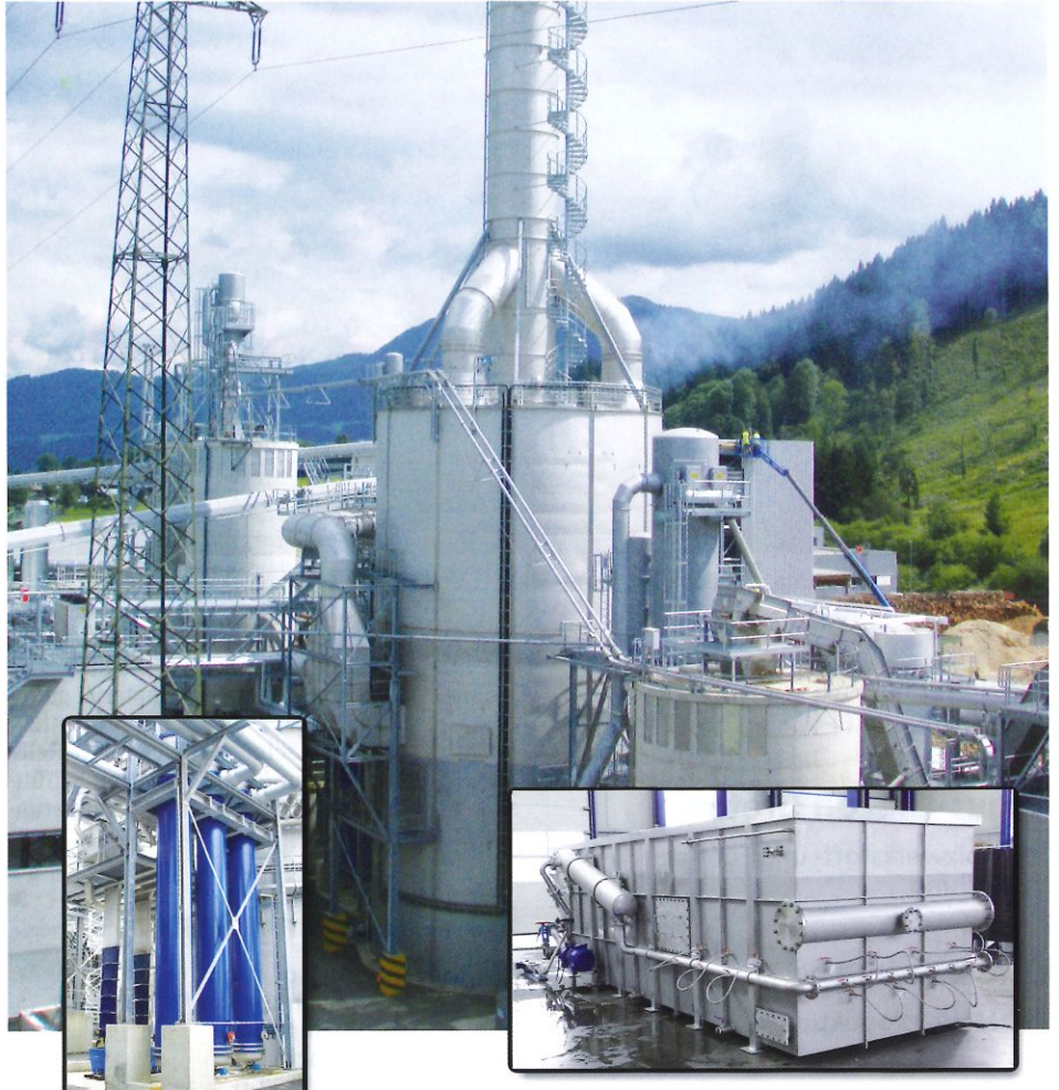
Abgasreinigung als Nass-E-Filter für Trockner mit Wärmeauskopplung und Flotation (EWK)
