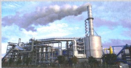
Abgasreinigung als Nass-E-Filter für Trockner mit Wärmeauskopplung und Flotation (EWK)
